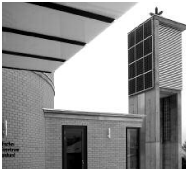
Kirchgemeinde Andelfingen: Neues Kirchzentrum St. Leonhard in Feuerthalen mit Sonnenkollektoren am Turm.
