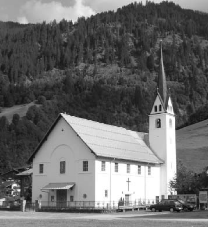
Die Pfarrkirche s.Placi der katholischen Kirchengemeinde Surrein/GR wurde 1695 als Kapelle erbaut und 1950 vergrössert und saniert. Die Pfarrgemeinde Surrein – 260 Seelen – liegt im Val Sumvitg am Fusse der Greinahochebene.
